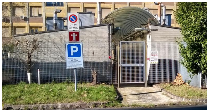
Figura 11: Locale di stoccaggio di agenti chimici e reflui, situato di fronte alla porta fornitori dell'edificio Fisica.
